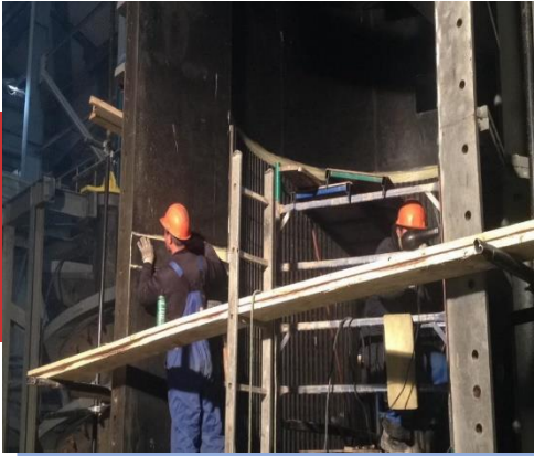
Футеровка и гуммирование в вертикальной мельнице
