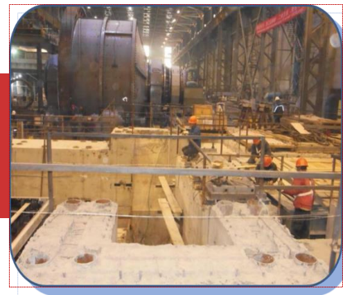
Подготовка фундамента МПСИ
