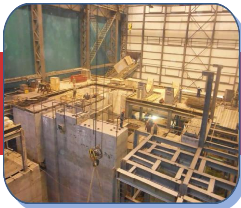
Подготовка фундамента МПСИ
