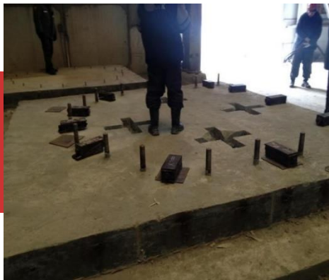
Подливка фундамента для вертикальной мельницы
