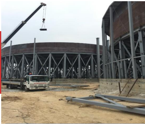
Строительство сгустителей кислого и щёлочного исполнения
