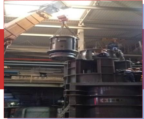
Монтаж двигателя и редуктора
